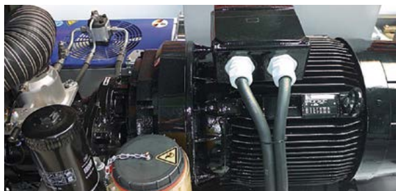
Le moteur électrique triphasé 30 kW
